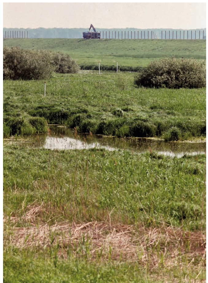
Abb. C: Aufstellung des Zauns auf dem fertiggestellten Grenzdeich. (Foto: Horst Wilkens, 1974)
