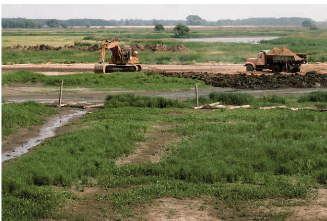
Abb. B: Der Bau des innerdeutschen Grenzdeichs erfolgte durch das Feuchtgrünland und die Senken des Wrechow-Polders und des Garbe-Polders. (Foto: Horst Wilkens, 1973)
