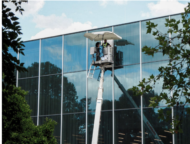
Das nachträgliche Bekleben des neuen Bauhausmuseums in Dessau im Jahr 2019 mit vogelschlagsicheren Folien hat das Thema in der Architektenschaft ankommen lassen. (Foto: Christoph Otto)
