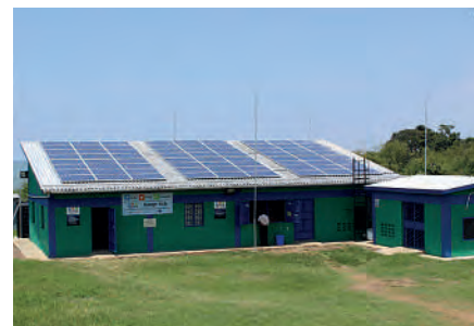
WE!Hub: Solar betriebene Energiestation. (Quelle: GNF)
