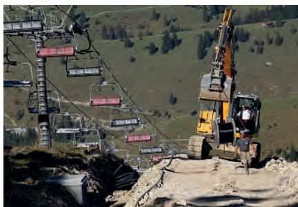
Baustelle Sudelfeld. (Quelle: DAV)
