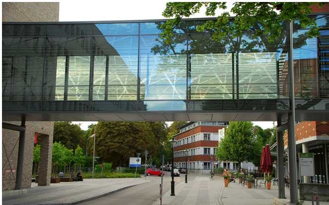
Flächige Markierungen sind das einzige Mittel, an transparenten Glasdurchsichten Vogelschlag zu verhindern. (Foto: Bernd-Ulrich Rudolph)
